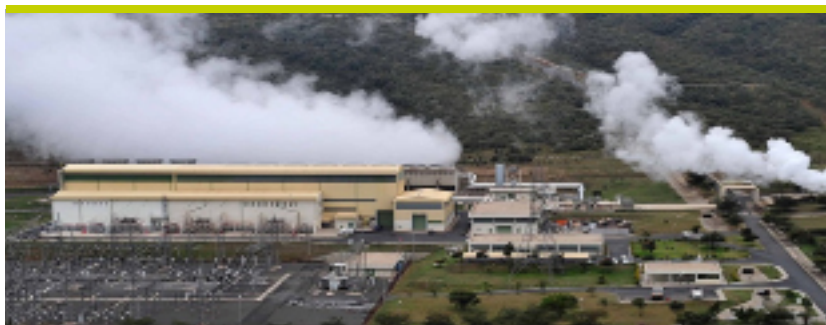
Abbildung 2: Luftaufnahme der Geothermieleistungsanlagen Olkaria II Quelle: ArGeo-Archiv (2020), zitiert in Nweke-Eze (2025)
